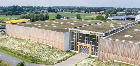
1 ha Biodiversitätsgründach auf einem Logistikzentrum der Firma Friedrich Lütvogt GmbH & Co. KG in Wagenfeld (Foto: Steffen Spitzner; Rechte: Friedrich Lütvogt GmbH & Co. KG)
