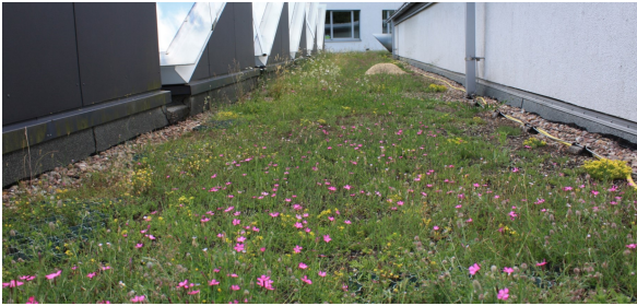
500 m 2 Gründach auf einem Hörsaalgebäude der Hochschule Osnabrück
