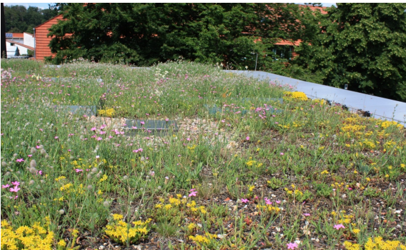
Extensive Begrünung eines Dachs der Hochschule Osnabrück
